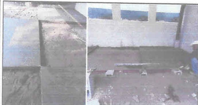
FOTO No.3 FUNDICIÓN DE PISO CON ACABADO ALISADO DENTRO DEL AULA
