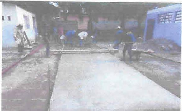
FOTO No. 5. FUNDICIÓN DE PISO DE TORTA DE CONCRETO EN PATIO
