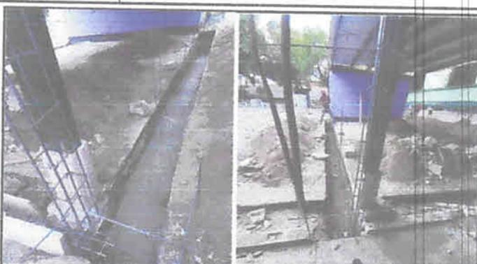
FOTO No. 2 CIMENTACIÓN Y CENTRADO DE COLUMNAS PARA LEVANTADO DE PARED DE BLOCK
