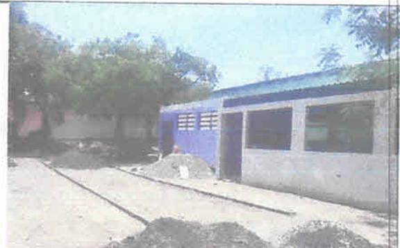
FOTO No.6. LEVANTADO DE PAREDES Y CAMBIO DE TECHO EN DIRECCIÓN
