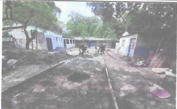
FOTO No. 1 NIVELACION DE TERRENO Y FORMALETEADO PARA FUNDICIÓN DE PISO DE TORTA DE CONCRETO EN PATIO
